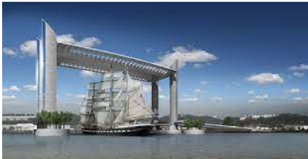
Bordeaux- Le Pont Chaban-Delmas, le plus récent. Son tablier se lève en 11 mn très précisément.
